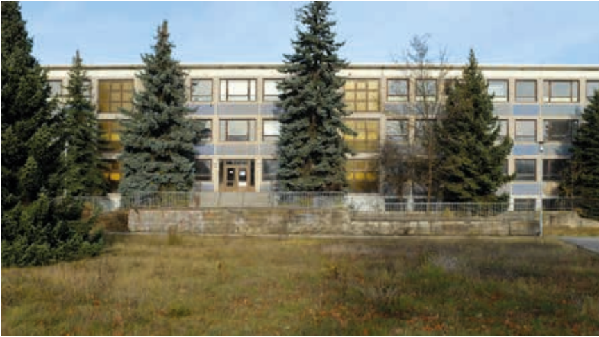
Gebäude mit Potential: ehem. Ingenieurschule für Glastechnik in der Brunnenstraße
