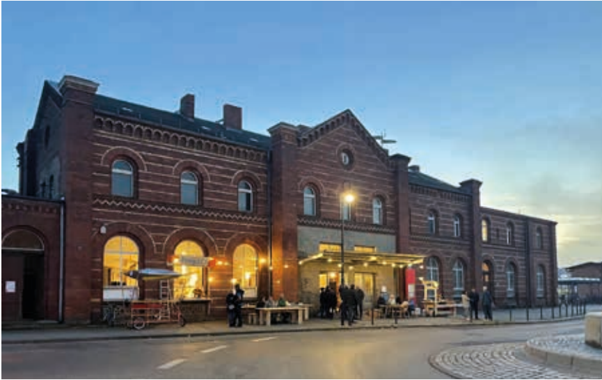
Bahnhofsgebäude während des Baufestivals im Oktober 2022
